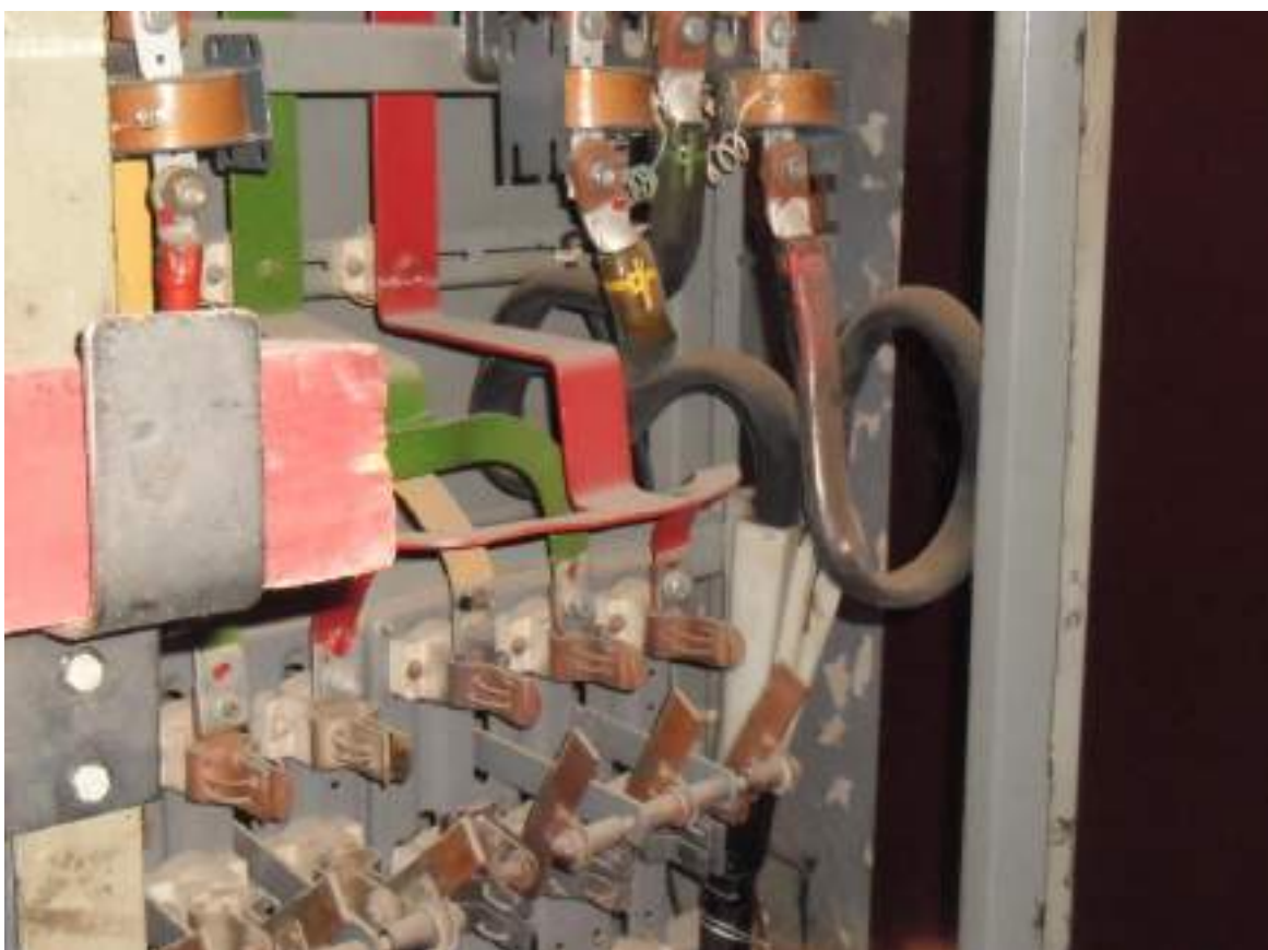
С задней стороны панелей частично отсутствуют защитные барьеры.
