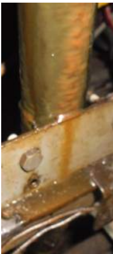
Ф.15 из концевой кабельной разделки происходит обильное выделение масла.
