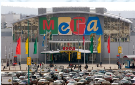
ТРЦ МЕГА Теплый Стан – АШАН – замер сопротивления изоляции кабелей.
